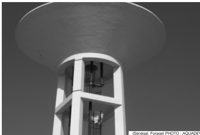
(Sénégal. Forage) PHOTO : AQUADEV
